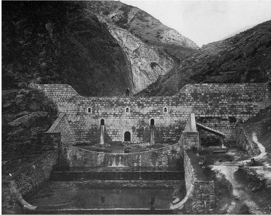
Primer dic i contradic ultims del barranc d'Enseu (1907). Aquestes van ser de les primeres obres de correcció que es van fer a l'Estat espanyol.
