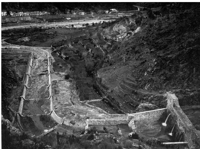
Detall del primer tram de la correcció hidrologicoforestal del barranc d'Enseu (1907). Al fons la Noguera Pallaresa i Gerri de la Sal. (Font: Llibre Imatges i Records de l'ajuntament de Baix Pallars, 1996)
